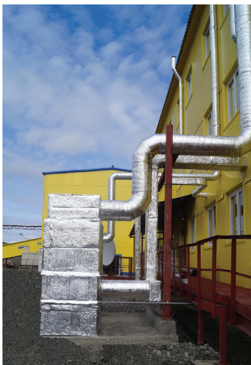
Рис. 2.2. Монтаж агрегатов АОУМ-ВИБРО с внешней теплоизоляцией Тарынская золоторудная компания (Оймяконский район, Якутия)
