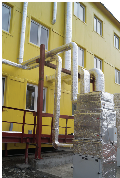
Рис. 2.2. Монтаж агрегатов АОУМ-ВИБРО с внешней теплоизоляцией Тарынская золоторудная компания (Оймяконский район, Якутия)
