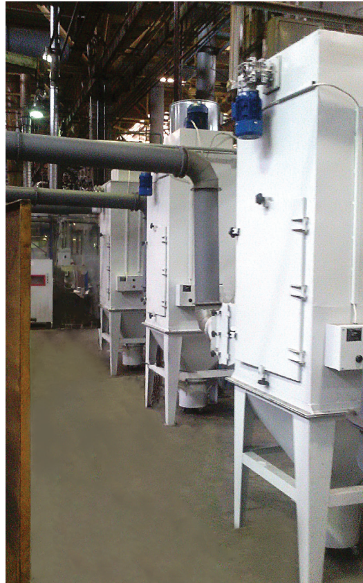
АОУМ-4000-В Участок обработки изделий из стеклопластика, «АВТОВАЗ»
